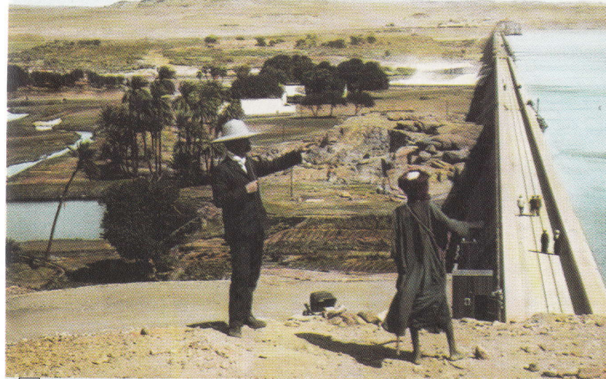
Primul baraj de la Assuan, prin 1902. Construcția a fost supraînălțată între 1912 și 1934 până la înălțimea de 44 m.
