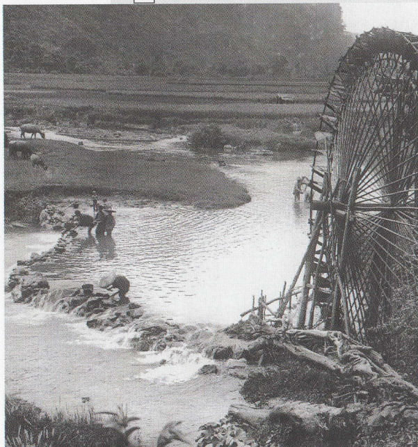
Tonkin, 1922. Roată elevatoare pentru irigații la frontiera chineză, în actualul Vietnam.
